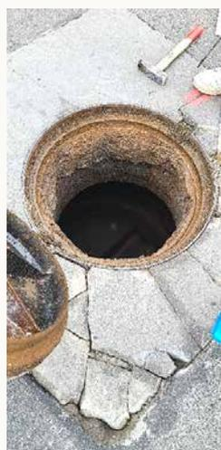
**Réparation des plaques tampon pluvial et assainissement** : nous entreprendrons la réparation des plaques tampon pluvial et d'assainissement à l'entrée de bourg, plus précisément avenue des Roches. Cette action contribuera à garantir un bon fonctionnement de nos réseaux sans que les plaques en surface et la chaussée ne soient davantage abimées. Le confortement de ces plaques permettra une circulation quotidienne de tous les véhicules en sécurité.
